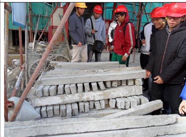
认识工地现场的预制钢筋混凝土过梁
