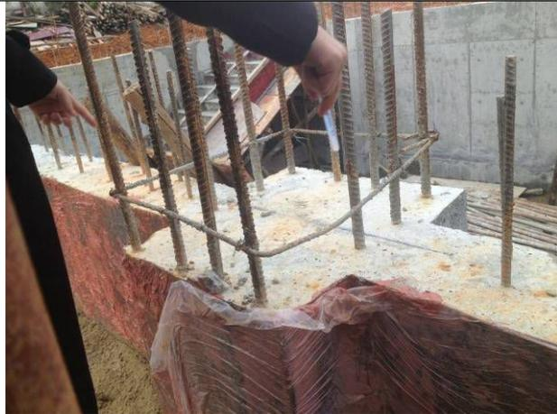
认识柱钢筋（纵向受力钢筋、箍筋）
