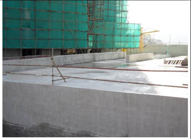
认识地下室顶板的反梁做法
